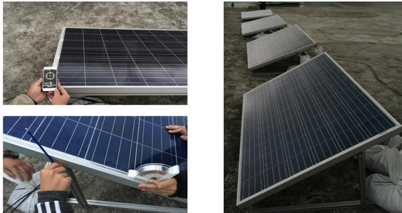
圖 3-8 實際架設太陽能發電系統
