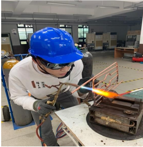
圖 16 散熱盤管焊接
