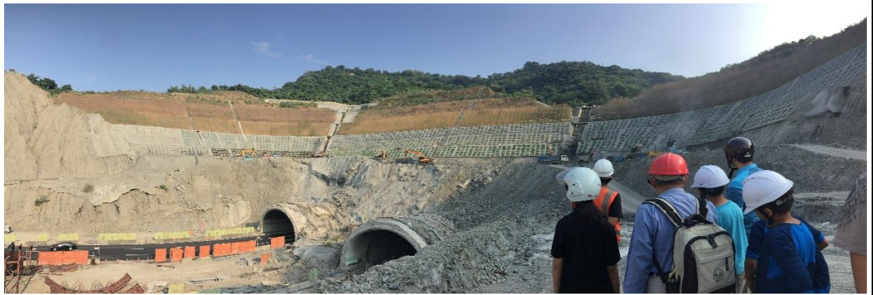
圖1-33-1:中寮隧道，範圍甚大的開挖區及開挖之護坡工程。
