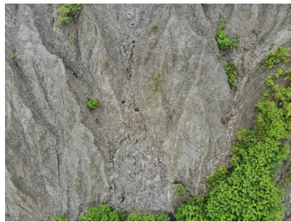
圖1-31-3: 大峽谷右側為順向坡，所以坡腳處有崩坍。
