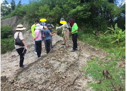
圖1-31-10: 附近可見10公分以內的夾層砂岩，且甚為破裂，為易滲入雨水的位置。
