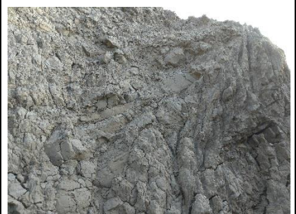
圖1-33-10: 除斷層泥外，夾層砂岩亦甚破碎。
