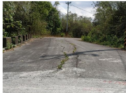
圖1-32-7:進入農塘兵工廠可見泥岩膨脹隆起，使道路產生裂縫。
