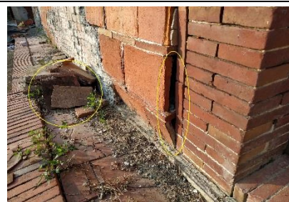
圖8-4：地面紅磚拱起，磚牆也因擠壓而龜裂。
