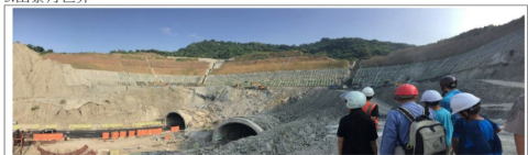
圖1-33-1: 中寮隧道，範圍甚大的開挖區及附設之護坡工程。
