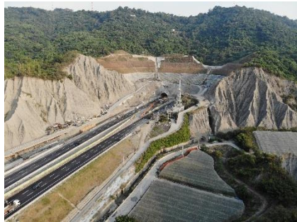
圖1-33-2: 中寮隧道有大量開挖的工地。
