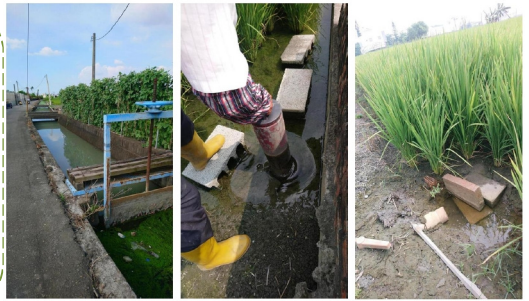
(1)八堡二圳灌溉水道 (2)水圳濁水進水口 (3)抽取地下水進水口。
